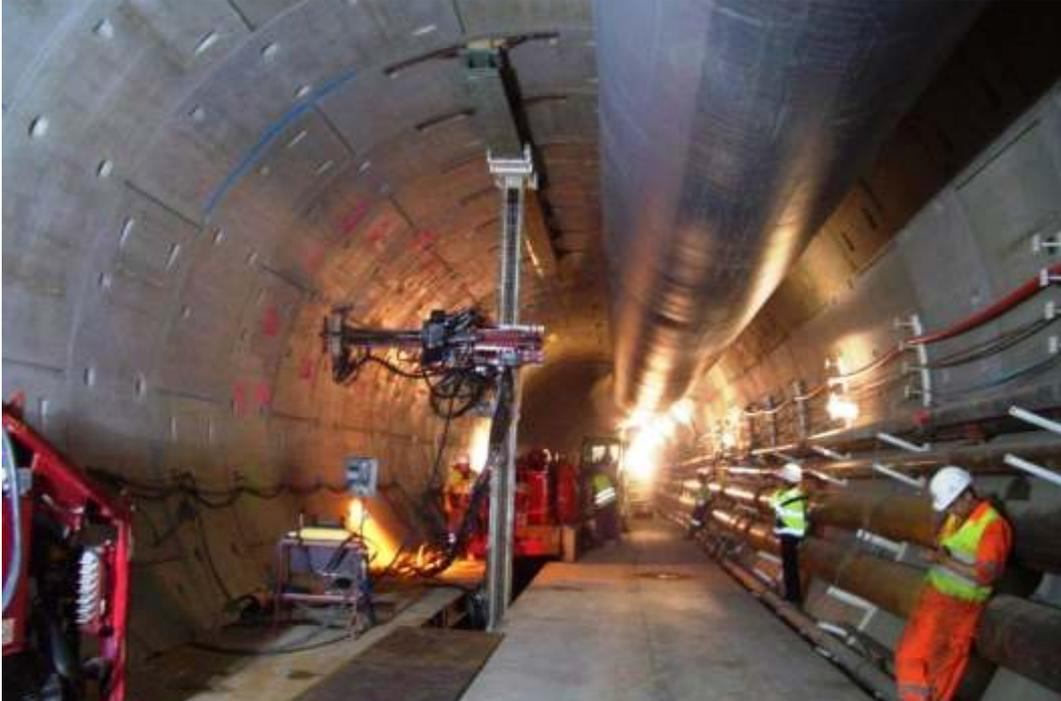
Sonda perforatrice montata sul mast verticale
