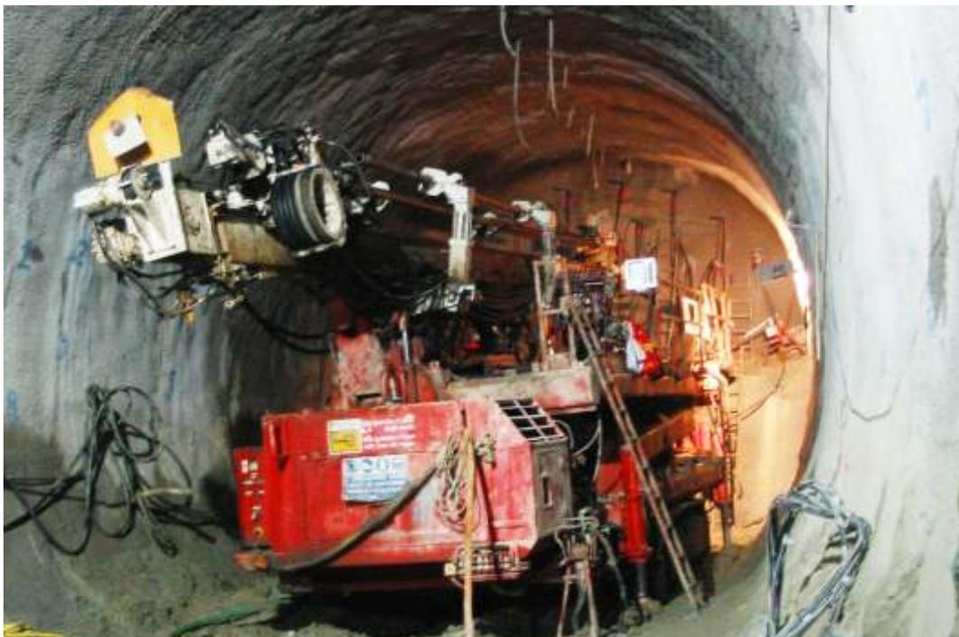
Sonda **RODIO SR 510** in perforazione sotto aria compressa
