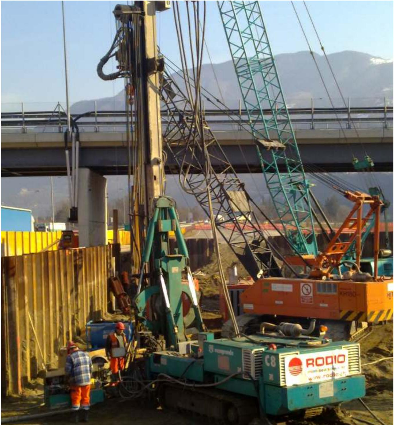
Sonda perforatrice Casagrande C8
