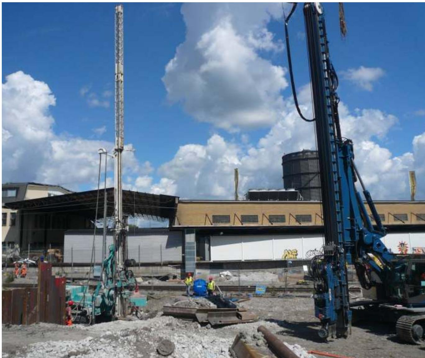
Sonda perforatrice Casagrande C8 Super
